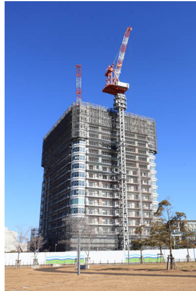
建設中の 高層マンション
